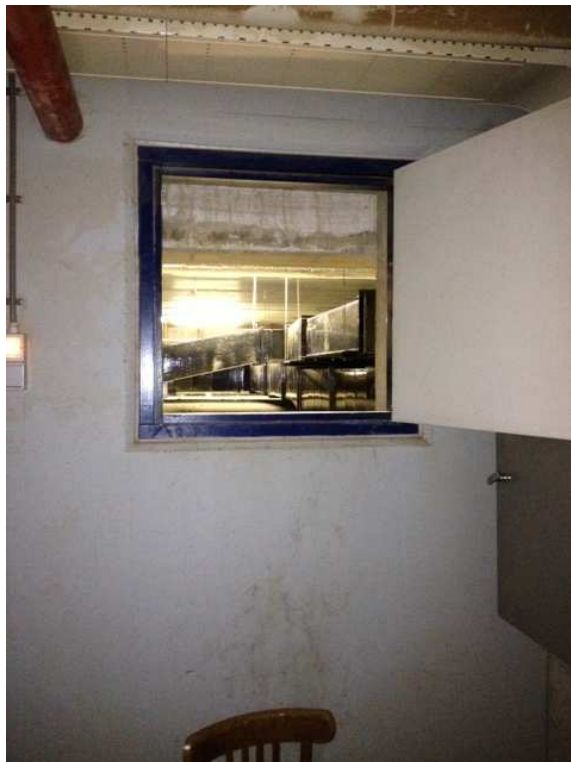
Foto 2: Toegang tot de kelder
